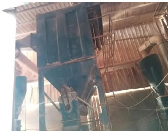
旋风除尘器（2#排气筒）
