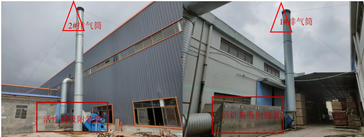
图 3-2 热压及贴面工序废气处理措施示意图
